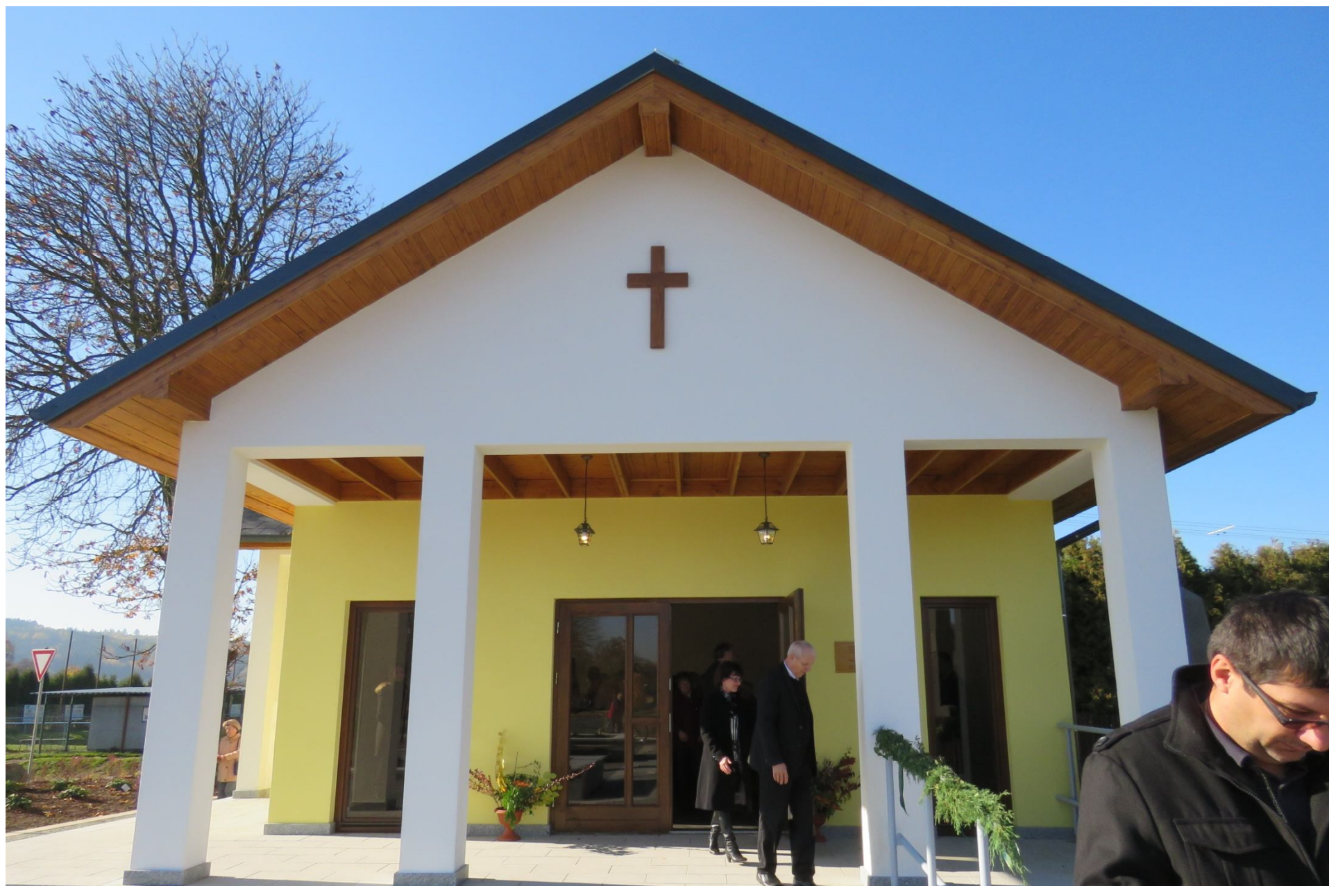
Revitalizace hřbitovní kaple ve Velkém Šenově
